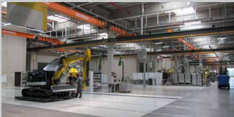
Průmyslová hala 50.000 m 2 vyztužená pouze vlákny Fibrofor High Grade, bezspará
