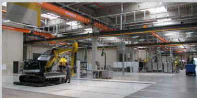
Průmyslová hala 50.000 m 2 vyztužená pouze vláknem Fibrofor High Grade, bezspárá
