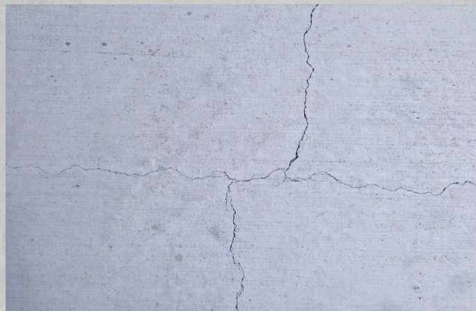
Betonová deska bez Green vláken = (mikrotrhliny)
