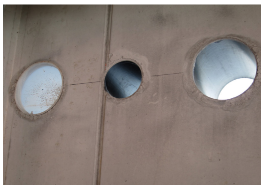
Pažnice HRD-FU po betonáži
