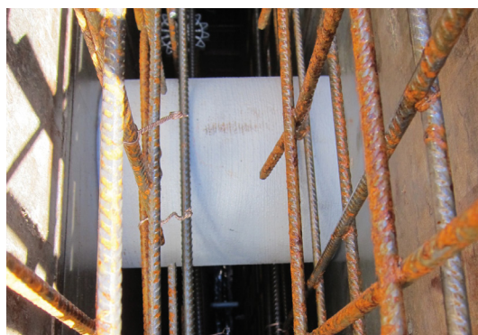
Pažnice HRD-FU upevněná v bednění
